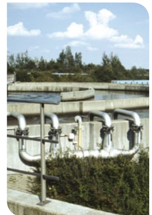
Klärbecken in Goslar.
