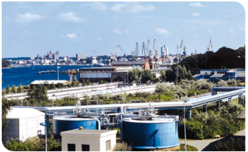
Zentrale Kläranlage Rostock.
